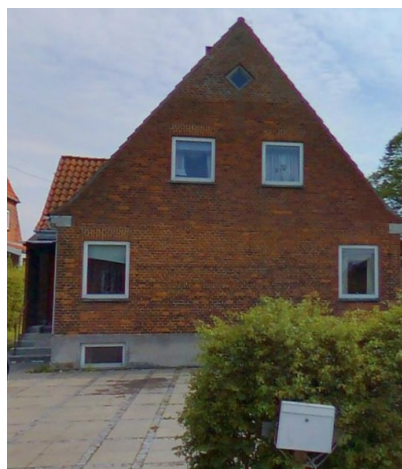
Fig. 2: Limfjordsvej 30 i dag. Foto: JVF
